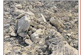
Runde und unförmige Natursteine wie bei einer alten Burg: Beim Bau des Gasthofs Storch in Menziken wurden vor bald 200 Jahren naturnahe Materialien verwendet. (Bild: msu.)
