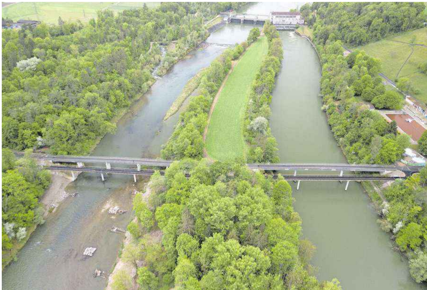
Die neuen Brücken über die Aare und den Kraftwerk-Unterwasserkanal stehen wenige Meter flussabwärts von den alten. Bild: Michael Küng
