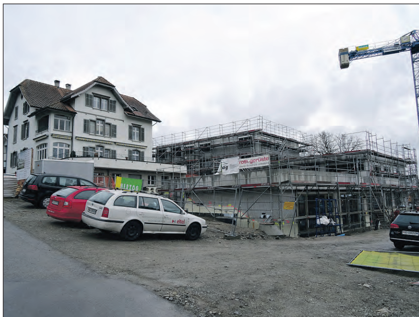
Gut auf Kurs: Mit der Realisierung des Ergänzungsbau «Breiti» in Reinach schliesst die Stiftung Lebenshilfe eine Platzlücke für ihre Bewohner. (Bild: mars.)
