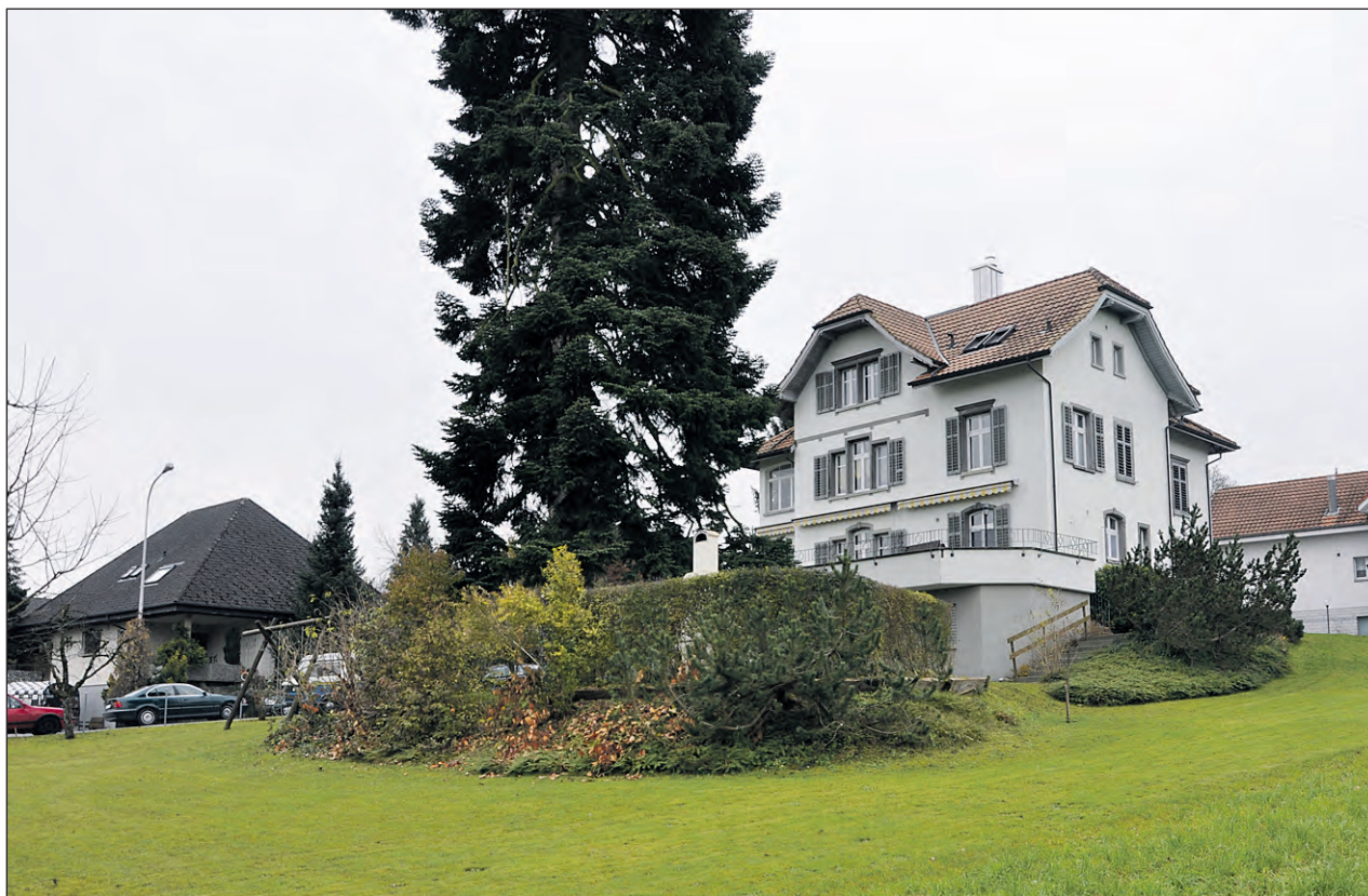
Wohnhaus Breite der Stiftung Lebenshilfe: hier an der Gigerstrasse soll in einem ergänzenden Neubau Raum für vier Wohngruppen und acht Plätze für Tagesbetreuung in zwei Gruppen unterteilt entstehen. (Bild: msu.)
